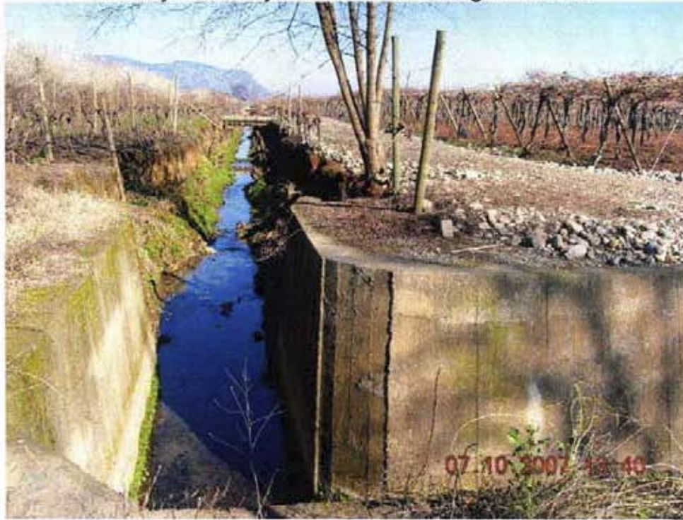
FOTO 9.6-2 Drenaje con zanjas en área de Codegua - Morza
